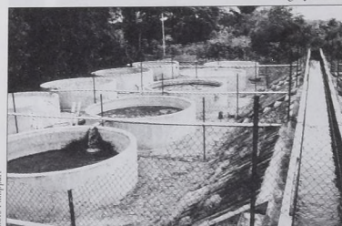
Vue des bassins d'élevage de poissons-chats. Station piscicole de Godomey, Bénin
