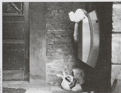
Dans le parking dit "de la chaufferie", les poubelles vertes (voir notre encadré) font des ravages...
