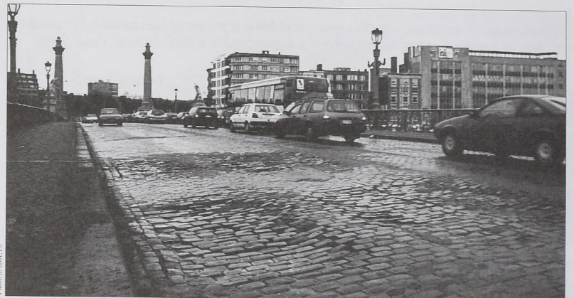
Le pavage du pont de Fragnée n'est plus approprié aux conditions actuelles du trafic. Conséquence : les pavés feront bientôt place au tarmac.
