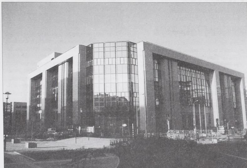
L'immeuble bruxellois Justus Lipsius, le nouveau bâtiment du Conseil des ministres de l'Union européenne, est depuis peu un terrain de travaux pratiques pour chercheurs et étudiants en thermodynamique.
